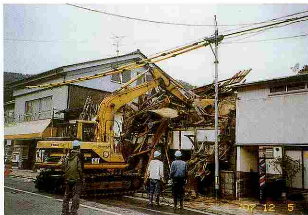
家屋の解体も公費で行った
