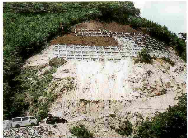
雨が降るたびに土砂崩れの心配も（大規模林道日野金城線）
