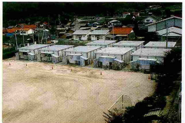
黒坂小学校校庭など町内4か所に応急仮設住宅28戸が建設された
