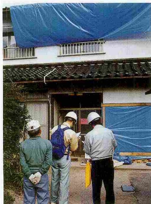
建物応急危険度判定、家屋被害調査を全戸実施
