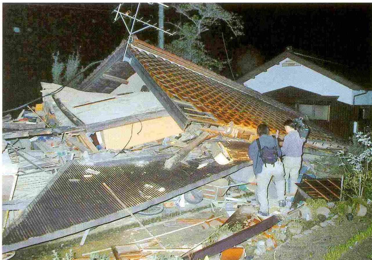
家屋被害は、全壊129戸、半壊441戸、一部破損945戸、計1,515戸の全世帯におよんだ(下榎地内) (写真：読売新聞大阪本社)
